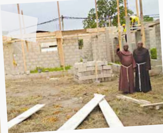
Fra Severin e fra Nicodemo nel cantiere della scuola, davanti alle aule in costruzione.
